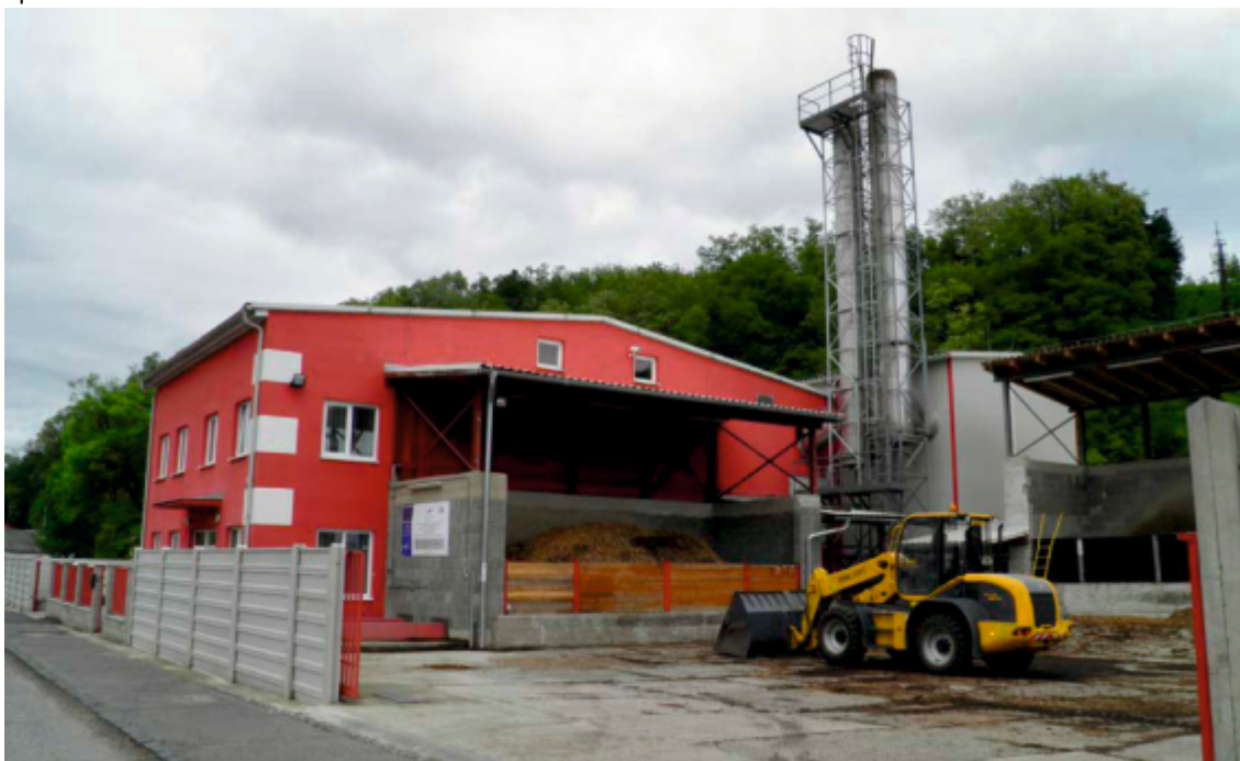
Figura 33. Imagine a centralei termice din Hnúšť'a cu un spațiu de depozitare a combustibililor și o sală a cazanelor (Sursa: INTECH, Slovacia).
