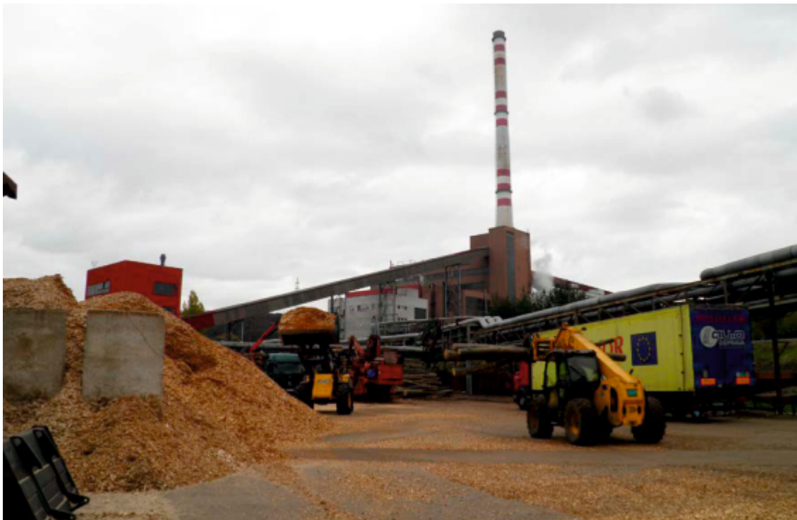
Figura 31. Centrala combinată de căldură și electricitate din Zvolen (Sursa: Otepka, 2013).
