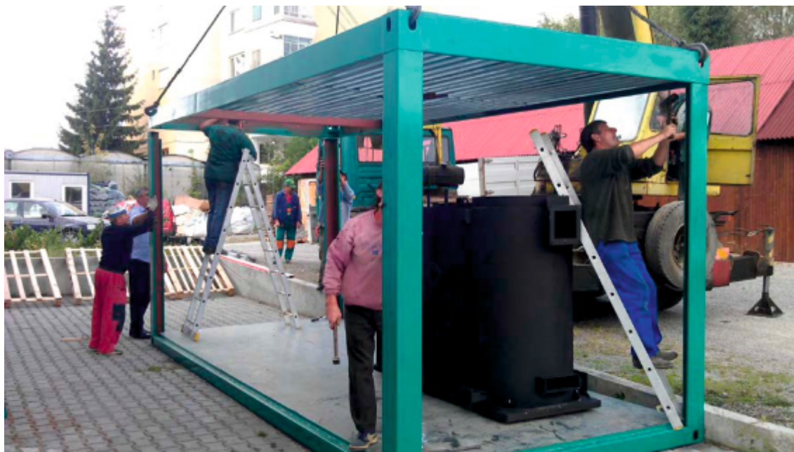
Figura 22. Compania COVIMM a decis să înlocuiască sistemul de încălzire existent cu un cazan nou pe biomasă (Sursa: COVIMM).
